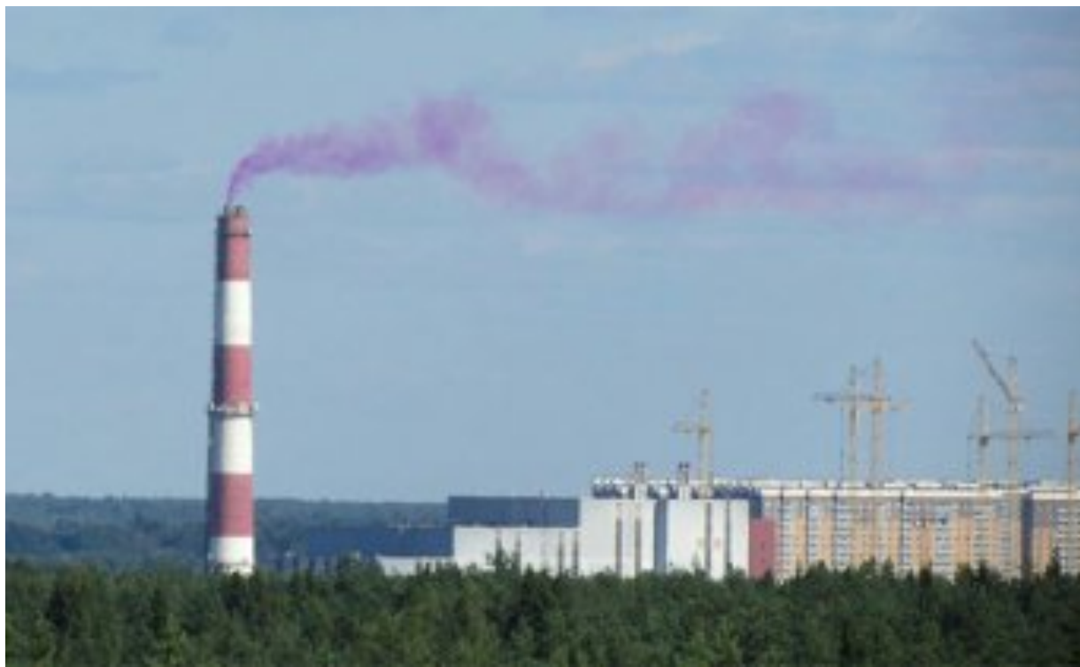
Розовый дым из трубы МСЗ-4 зафиксирован 7 августа 2018 года
